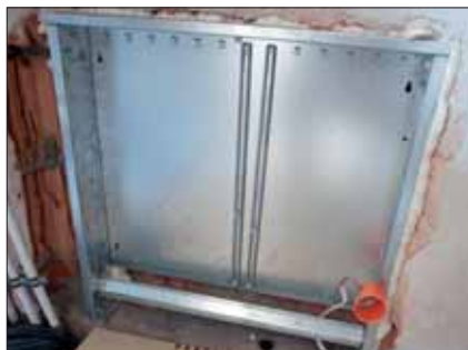
1. Montaż szafki rozdzielacza.
