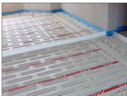
7. Montaż profili dylatacyjnych.
