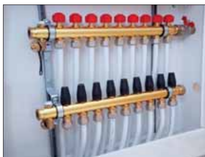
8. Przeprowadzenie próby ciśnieniowej.
