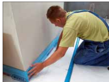
3. Rozłożenie taśmy dylatacyjnej przyściennej.
