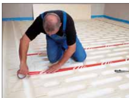
5. Uszczelnienie połączeń stykowych taśmą izolacyjną.
