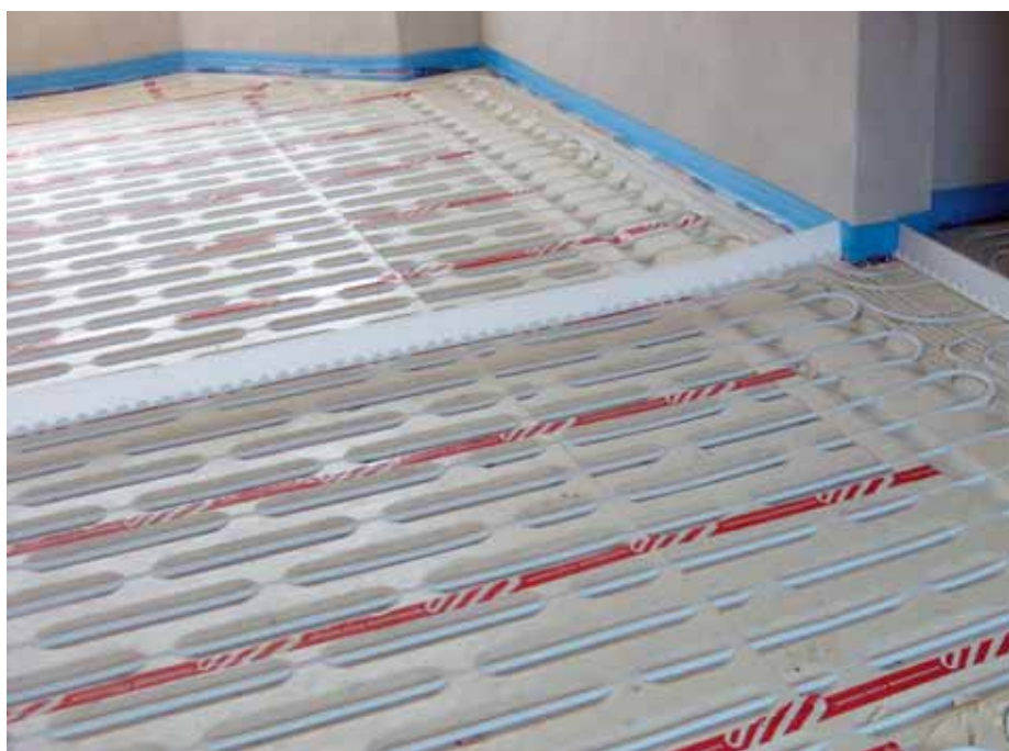
Elementy dylatacji – taśma brzegowa i profile dylatacyjne przed wykonaniem wylewki
