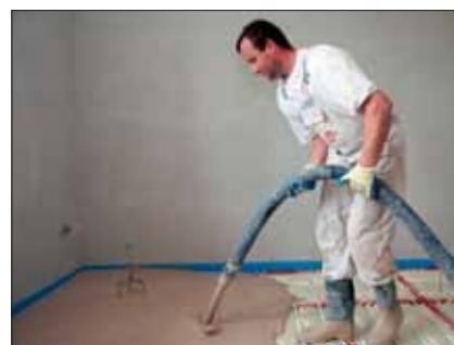
9. Wykonanie wylewki jastrychowej.
